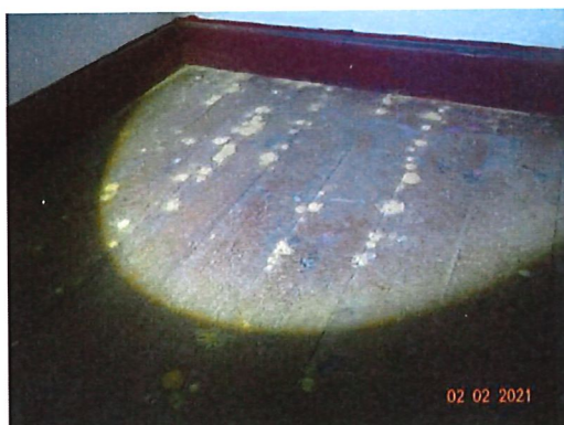
Bild 13: Fint spån lokalt mellan golvbrädor, tyder på insketer
