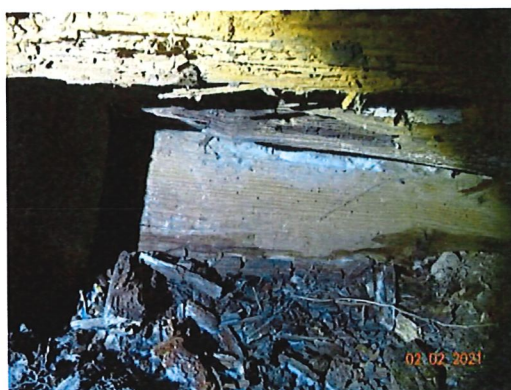
Bild 11: Bjälklag ligger direkt mot mark
