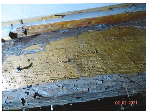
Bild 9: Små hål tyder på insektangrepp
