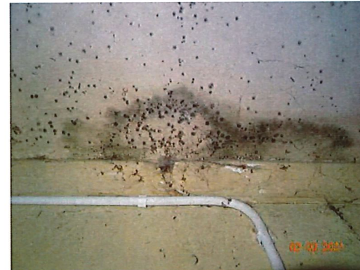
Bild 6: Fuktbläckar och mögelskador i tak
